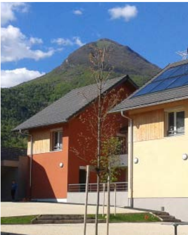
Commune de Cruet, opération de 50 logements neufs, mixité sociale, habitat groupé, énergie solaire, espace public.
