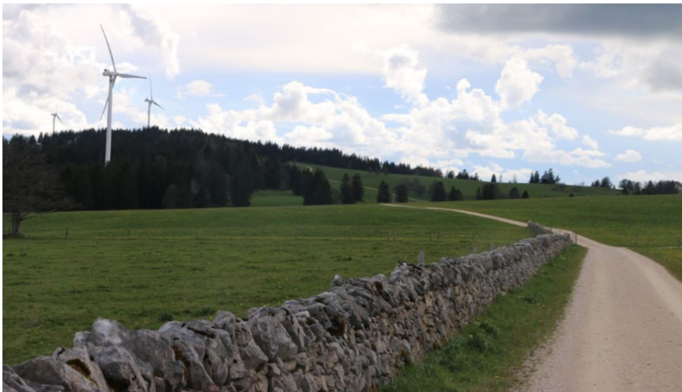
Parc éolien de Mont-Soleil et Mont-Crosin
