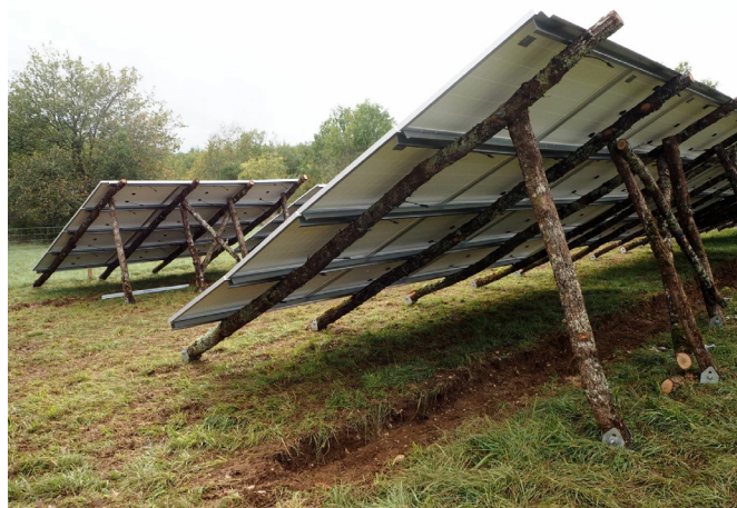
Parc photovoltaïque de Céléwatt : des panneaux portés par du bois brut ©Energie Partagée
